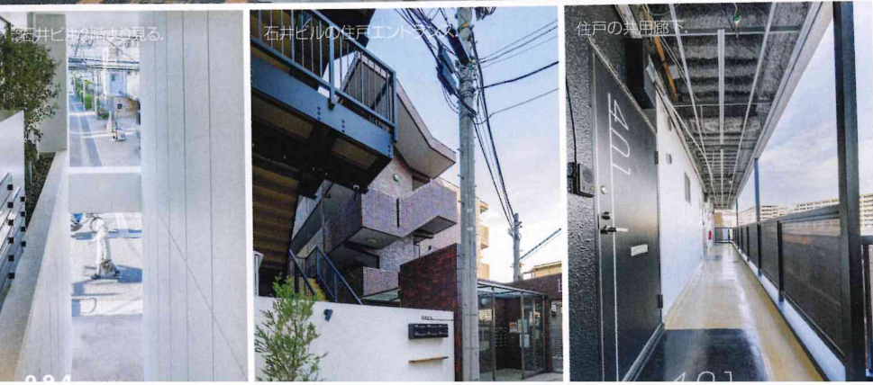
南側壁面に設置したサイン。各階の用途の違いに対応でき、なおかつ一体的な体験となるよう、同じ光源の反復と、アンダーラインによるデザインに統一した。隣接する賃貸住宅も案内している。
